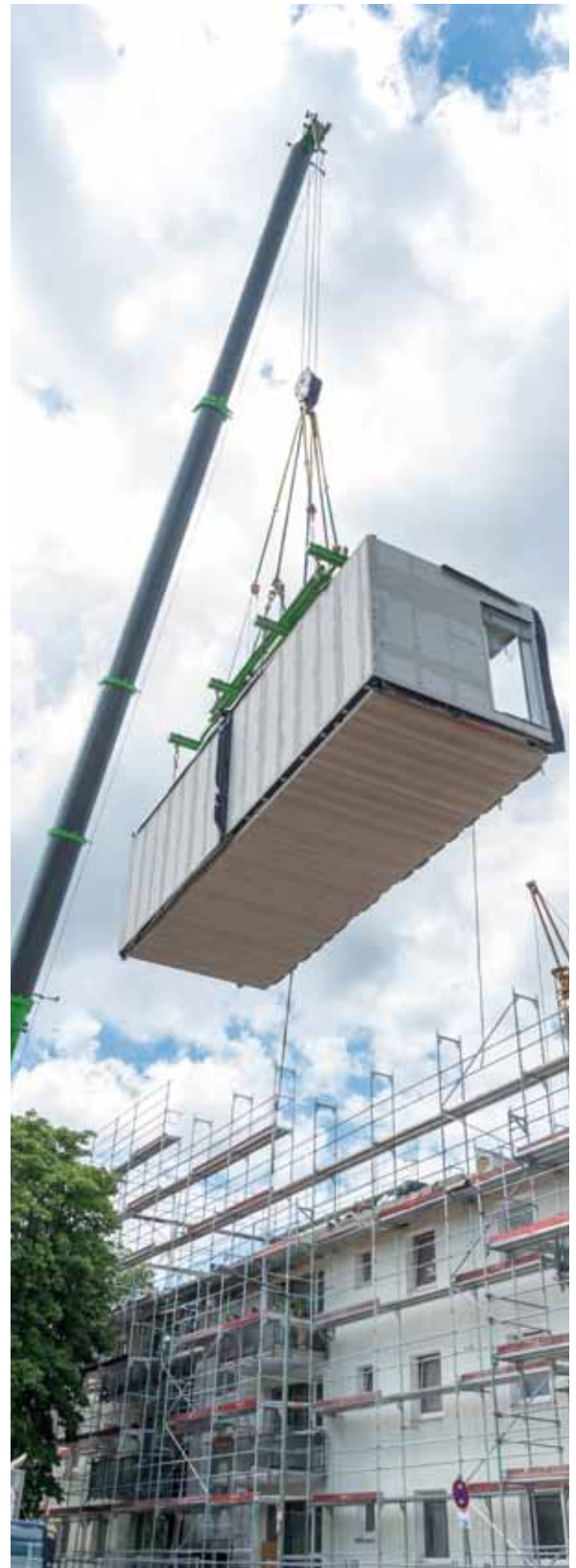
Bild: Aufstockung der Platensiedlung, Frankfurt am Main
